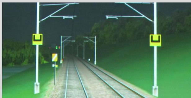
Abb. 12: Beim Einschaltsignal der Schutzstrecke befindet sich das Anfangssignal für die Langsamfahrstelle von 80 km/h.
