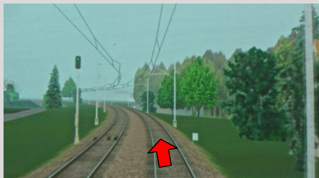
Abb. 6: Der Lokführer hat die Signale des linken Gleises zu beachten. Im rechten Gleis fehlen die Streckengeräte für die Zugsicherung (Pfeil).
