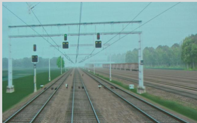
Abb. 1: Einfahrtsignal Däniken. Das Ausfahrsvorsignal zeigt Warnung.
