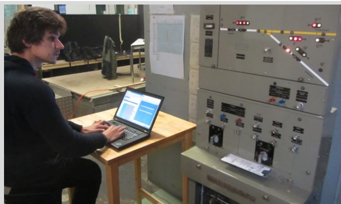
Abb. 6: Inbetriebnahme der Middleware und der Stellwerklogik für das Stellwerk Obermatt.
