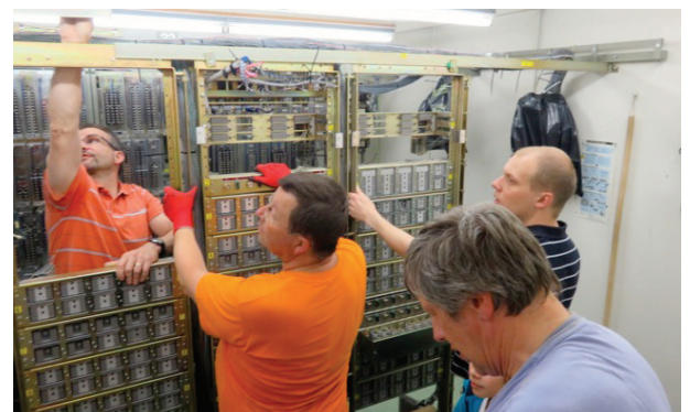
Die Satzgestellreihen werden - möglichst unter Beibehaltung der bestehenden Drahtverbindungen - ausgebaut.
