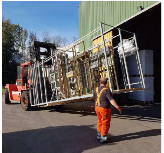
Einfahrt des Relaisraums des Stellwerks «Doppelschwand-Romoos» in die Lagerhalle in Lyss.
