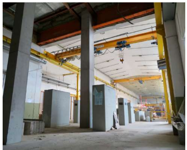
Die ursprüngliche Halle im Bernapark in Deisswil wurde nach dem Umzug des DESM-Inventars geräumt und gereinigt. Die Abgabe erfolgte am 3. Dezember 2019.
